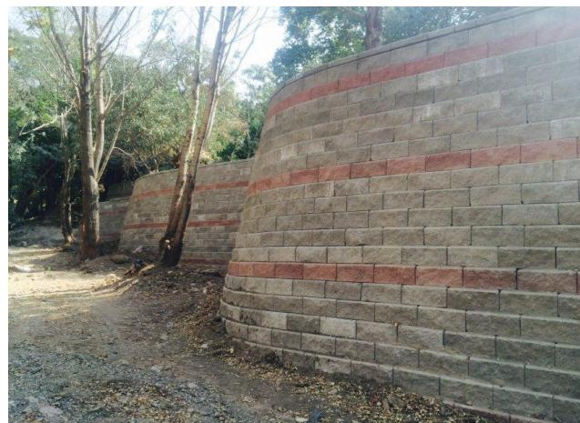
برای دیوارهایی با ارتفاع بیشتر از ۱/۲ متر می باشند لایه های ژئوگرید (الیاف پلیمری) با قابلیت کشش بالا جهت تحکیم شیب ها و نگهداری خاک ) بصورت افقی و در فواصل ۴۰ سانتی متری نصب شوند تا پایداری دیوار تامین گردد.
