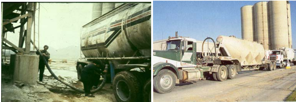
شکل ۱ نحوه انتقال سیمان، (سمت راست) از سیلو به بونکر، (سمت چپ) تخلیه سیمان به داخل سیلو
