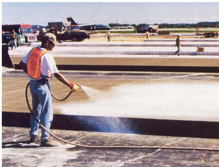
شکل ۴ روش عمل‌آوری با ماده شیمیایی غشایی
