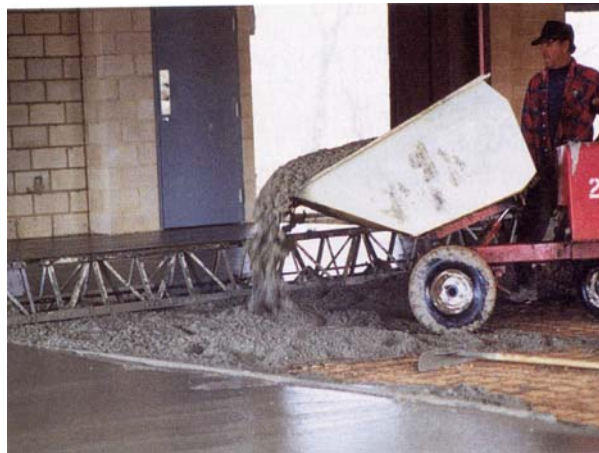
شکل ۳ روش صحیح ریختن بتن
