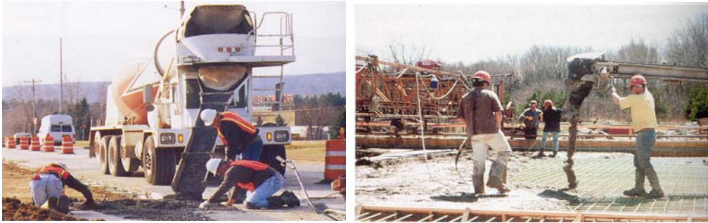
شکل ۲ ریختن بتن در نزدیکی محل مورد نیاز
