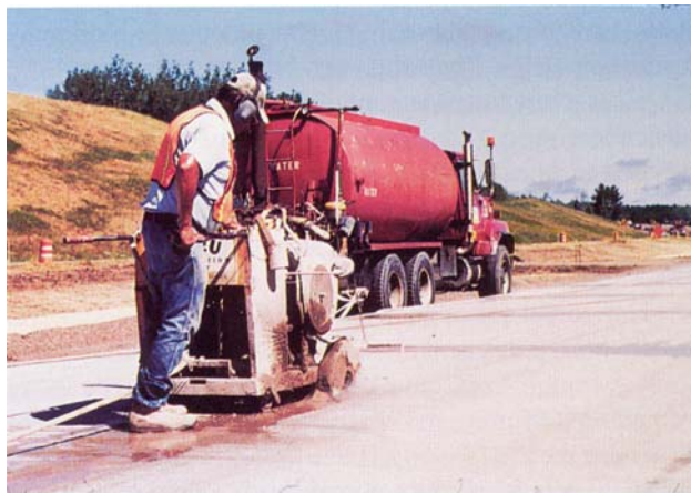
شکل ۱ استفاده از دستگاه برش برای ایجاد درز
