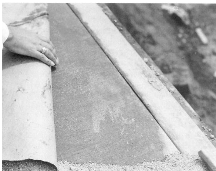
شکل ۳ عمل آوری عایقی (پوشش‌های مرکب)
