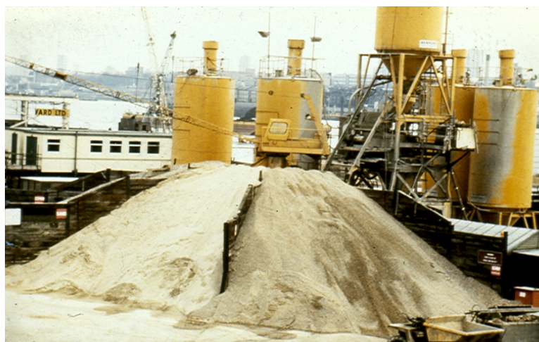
شکل ۶ استفاده از دیوار جدا کننده در نگهداری سنگدانه‌ها
