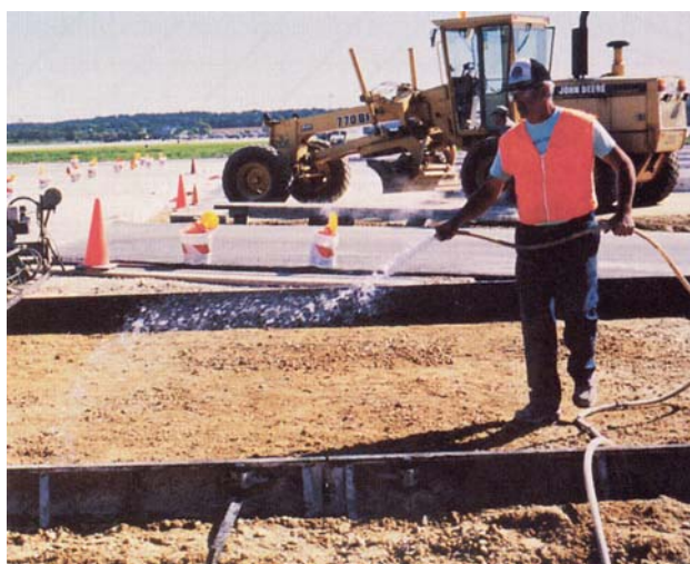
شکل ۲ آب پاشی روی سطح زمین، قبل از بتن ریزی در هوای گرم، برای کاهش دما
