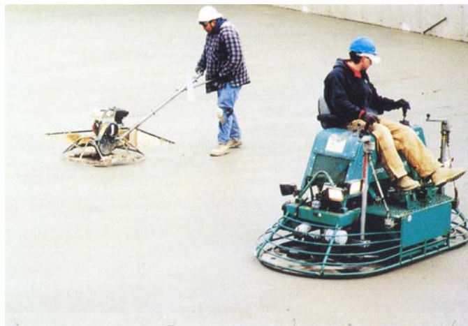
شکل ۶ پرداخت نهایی با ابزار مکانیکی
