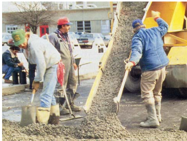
شکل ۴ انتقال بتن با استفاده از سطح شیب‌دار
