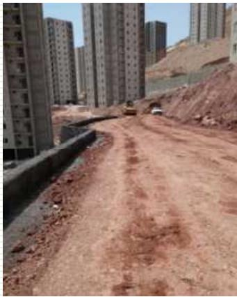
نمایی از لغزش رخداده در هنگام اجرای یکی از دیوارهای پروژه پس از اتفاق برای اولین بار یک زمین شناس مهندس از پروژه بازدید کرد.
